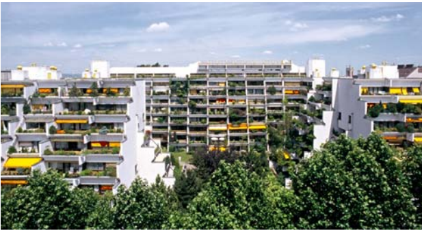
Im Bild: Wohnhausanlage Inzerdorferstraße in Wien © Harry Glück
