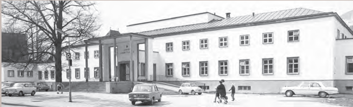
Fotos: Architekturzentrum Wien, Sammlung
