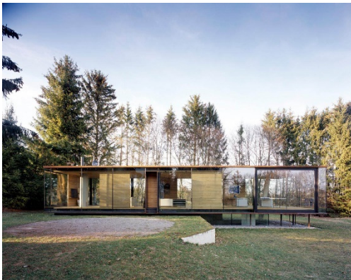
Atelier im Currypark, Riederau © Architektur und Foto: Beer Bembé Dellinger Architekten und Stadtplaner GmbH
