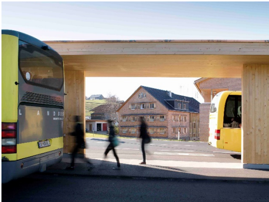
Bushaltestelle Krumbach © Architektur: ARGE Bechter Zaffignani Architekten ZT GmbH, Architekt Bernardo Bader ZT GmbH und Dipl.-Ing. Hermann Kaufmann ZT GmbH, Foto: Adolf Bereuter
